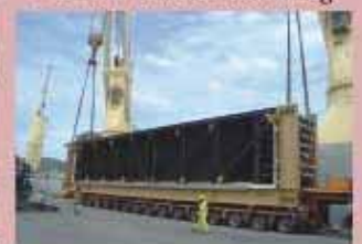
▼ Bartow - HRSG Box loading
